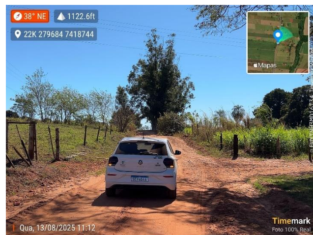
Foto 11- Presença revestimento primário (cascalho).
